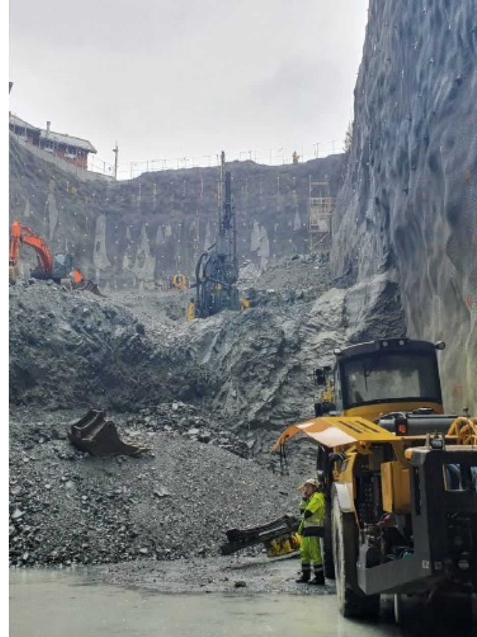
Haukeland underjordiske holdeplass, Bybanen Utbygging
